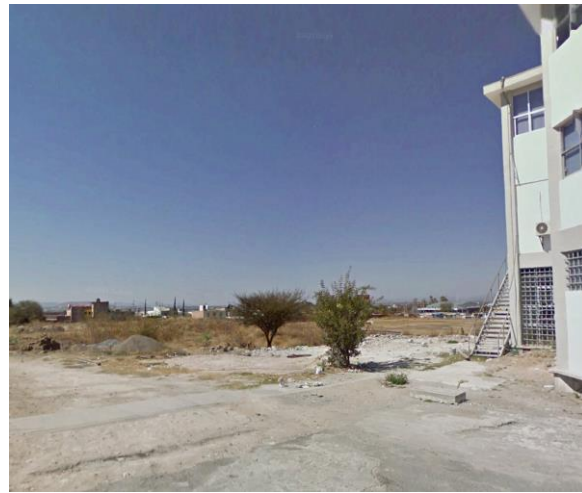
F1: Fachada principal
