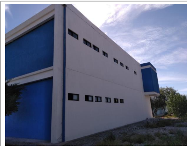
F3: Fachada lateral oriente
