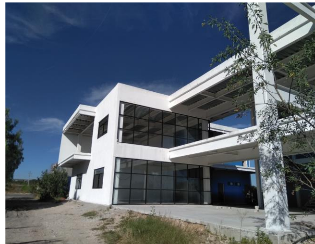
F1: Fachada principal
