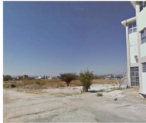
F1: Fachada principal
