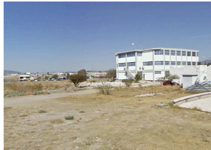
F2: Fachada lateral poniente
