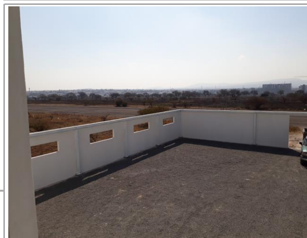
F3: Fachada lateral oriente
