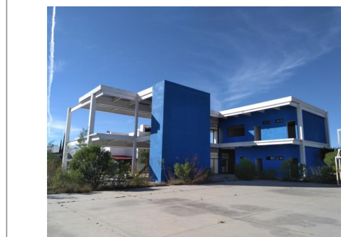
F2: Fachada lateral poniente
