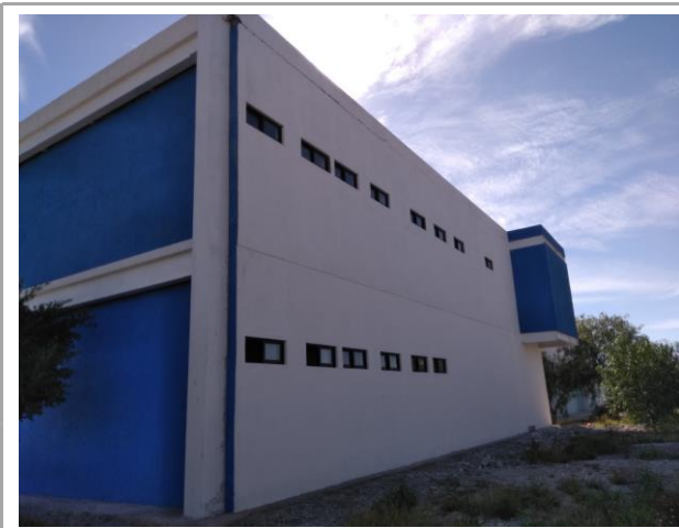
F3: Fachada lateral oriente
