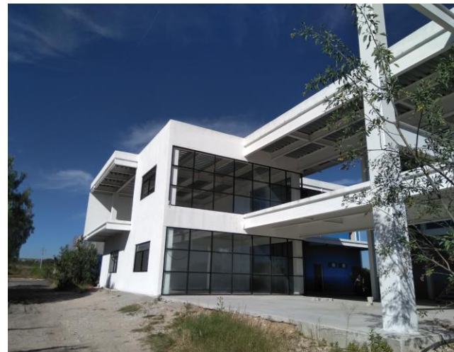
F1: Fachada principal
