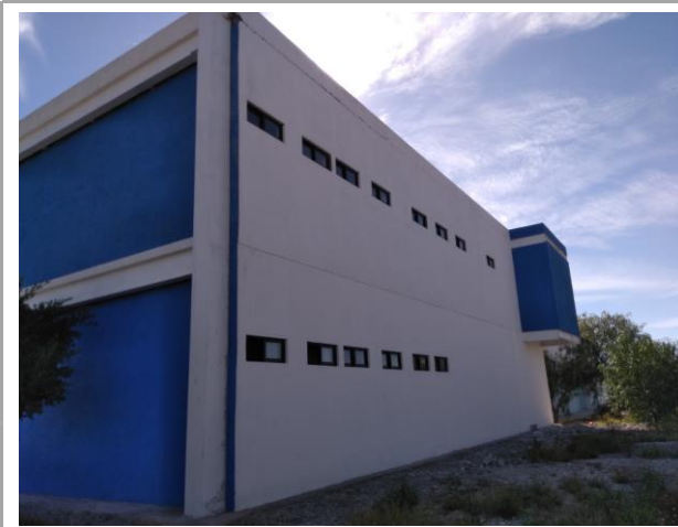
F3: Fachada lateral oriente
