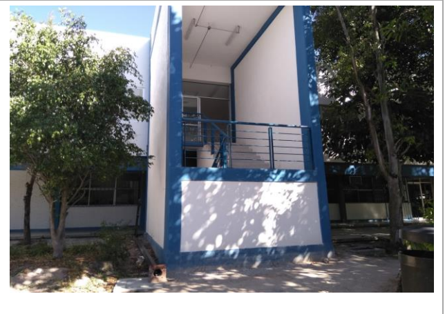
F1: Colocacion de barandal y pintura.
