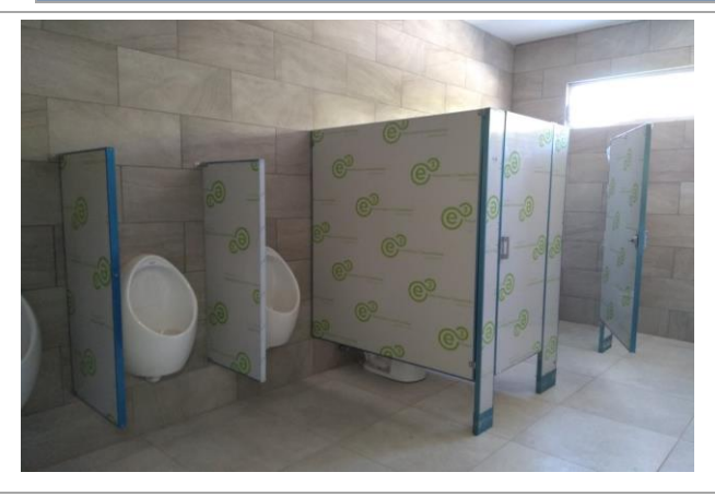
F4: Complemento de instalacion electrica y pintura en muros interiores.
