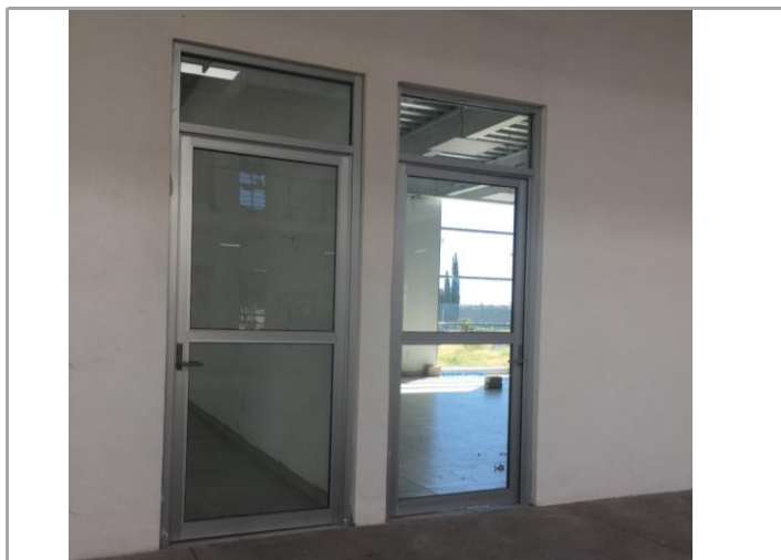
F1: Fachada principal
