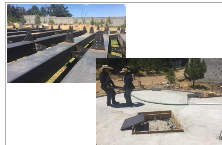
F5: Habilitado de vigas en general
