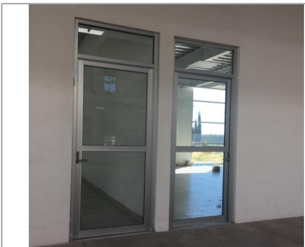
F1: Fachada principal
