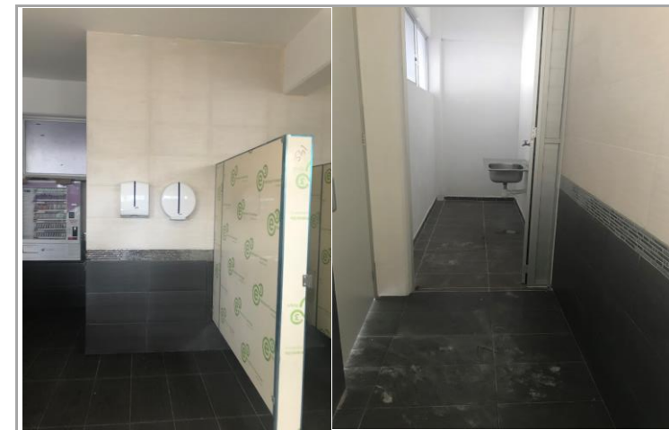
F5: Interior de aula
