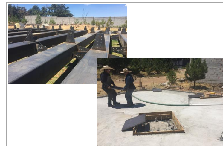
F5: Habilitado de vigas en general
